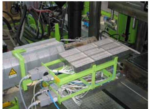
Strahlerfeld an der Spritzpresse
